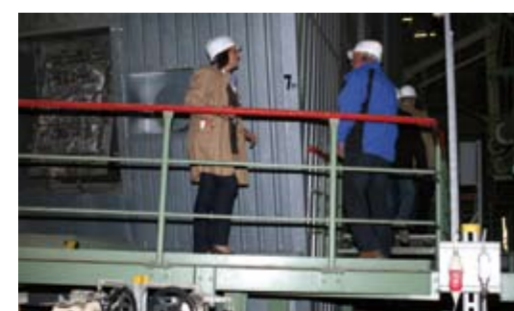
Hier im Kessel wird das Heizöl verbrannt und das Speisewasser verdampft.
